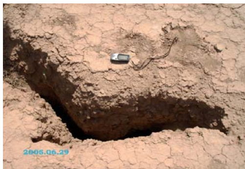
شکل ۲- الف ترک‌ها و شکستگی‌های زمین در رستاق
