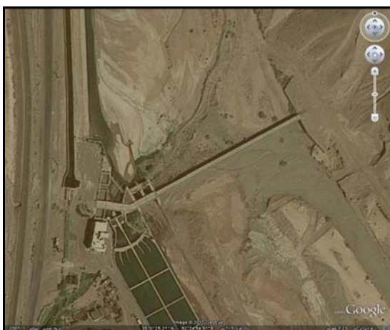
شکل ۴- احداث بند در راس مخروط افکنه گرمسار
