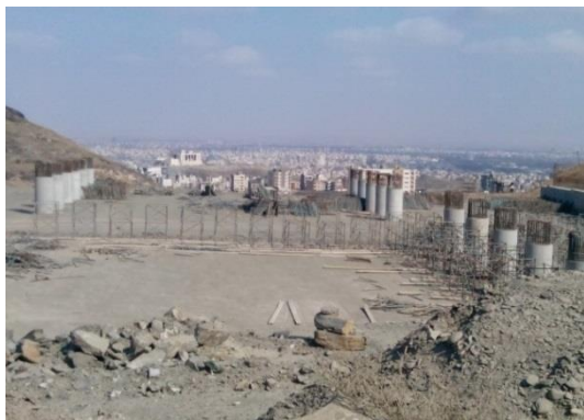
شکل ۷. بستر یک رودخانه در حال تخریب و جاده‌سازی
