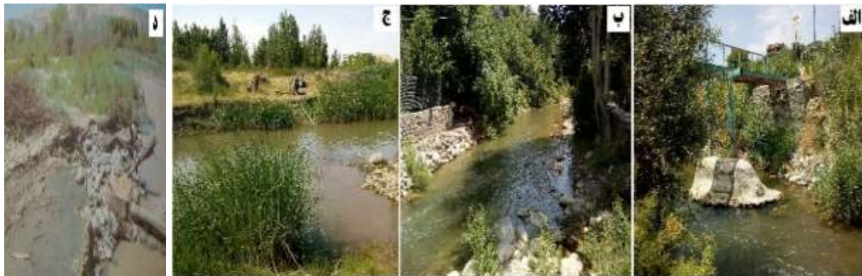
شکل ۹. نمونه‌هایی از دخالت‌های انسانی در رودخانه گیوی‌چای؛ الف. احداث پل‌ها؛ ب. ایجاد دیواره‌ها و فنس‌کشی‌ها و تنگ‌کردن بستر رودخانه؛ ج. پمپاژ آب رودخانه؛ د. ریختن زباله‌ها و نخاله‌ها در اطراف رودخانه
